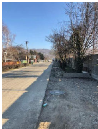
Canalizare Str Stadionului
