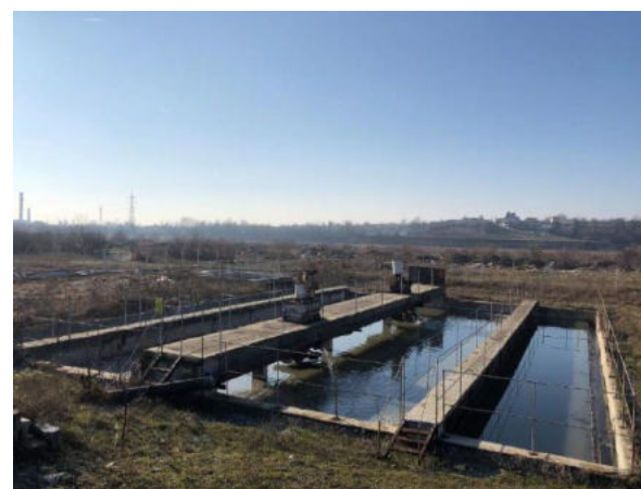
Modernizare și extindere stație de epurare
